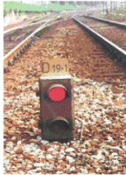
Exemple de signal d'arrêt lumineux fermé (desservi) à fleur de sol
