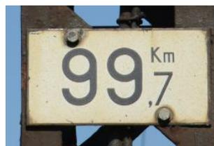
L'inscription portée sur la plaque de repérage est précédée de la lettre "C" (ou "C<sup>V</sup>") s'il s'agit d'un panneau portant un carré (ou un carré violet), des lettres "GA" s'il s'agit d'un guidon d'arrêt.
