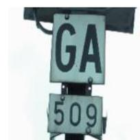
Sur les plates-formes à plus de deux voies, le kilométrage figurant sur la plaque de repérage peut, s'il y a lieu, être complété par la désignation abrégée de la voie à laquelle s'adresse le signal ou le groupe de signaux considéré.
