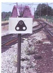
Le panneau d'arrêt pour petits mouvements est constitué d'un panneau rectangulaire comportant la silhouette d'un petit signal d'arrêt. Il est muni d'une plaque d'identification comportant les lettres "PK", un numéro et éventuellement un tiret suivi d'une lettre qui indique la zone du poste dans laquelle est implanté le signal.
