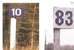
Les bornes hectométriques sont placées alternativement d'un côté et de l'autre de la ligne. Le kilomètre est rappelé sur le côté du support.
