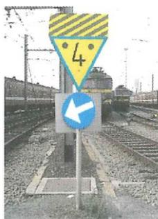
Lorsque la réduction de vitesse signalisée par panneaux est supérieure ou égale à 50 km/h, un second panneau servant de rappel est généralement implanté en aval du premier. Un panneau complémentaire "bis" surmonte alors ces panneaux de rappel.
