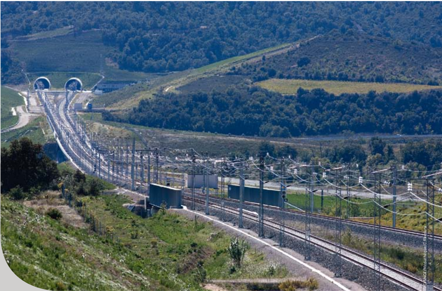
Mise en service de la partie française de la section de ligne Perpignan-Figueras, première infrastructure rattachée au domaine de compétence de l'EPSF au titre des autres réseaux ferroviaires présentant des caractéristiques d'exploitation comparables à celles du réseau ferré national.
